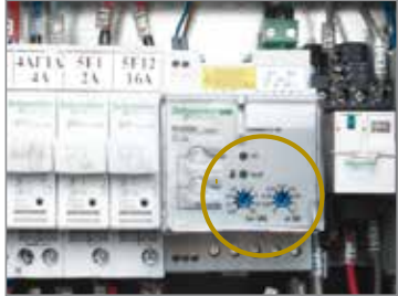
▲ Earth leakage protection Protection différentielle
